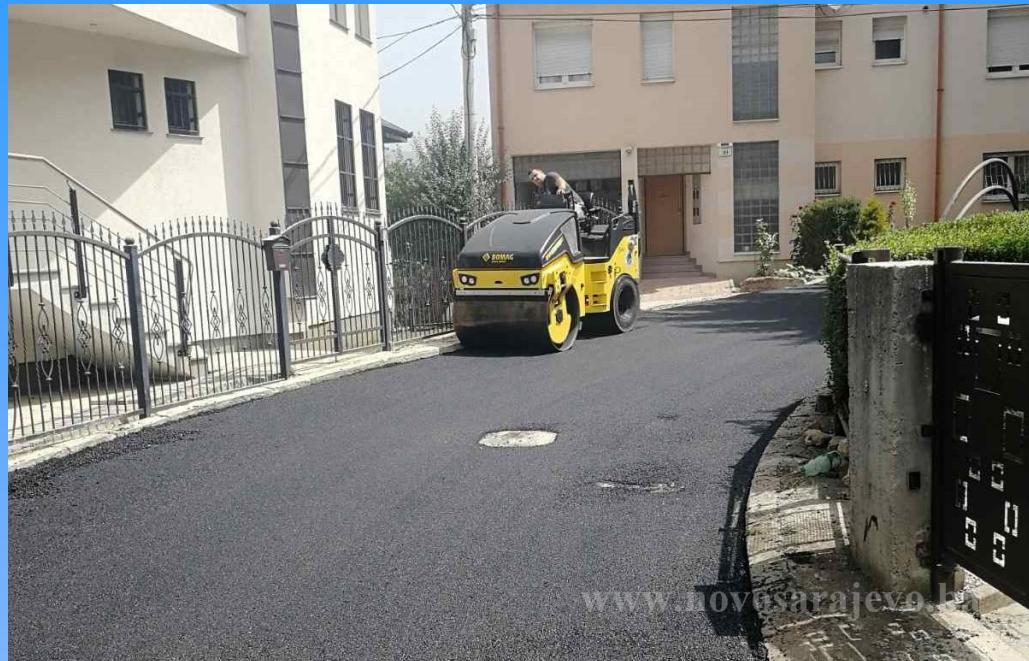
Nakon što je završena rekonstrukcija vodovodne mreže u dužini od 170 metara i izgradnja kućnih priključaka vode na novu mrežu izvedeni su radovi na ugradnji asfaltnog zastora na kolovoznoj konstrukciji u ulici Kupreška.
